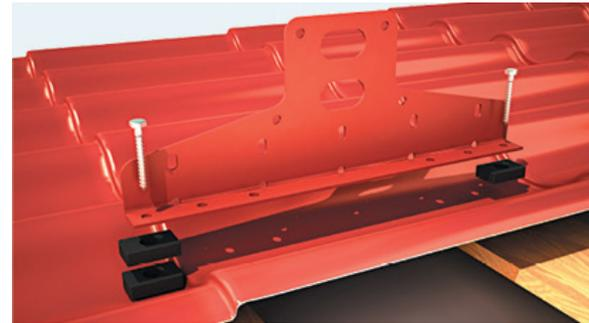
**1/** Разместите универсальные кронштейны на кровле и просверлите отверстия. Кронштейны крепятся к доскам обрешетки строго вниз волны. Уплотнители под кронштейны устанавливаются по месту в зависимости от вида кровли.
